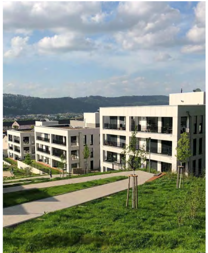
Trier, Castelnau - Fertigstellung 2017, 42 Wohnungen mit Tiefgaragen
